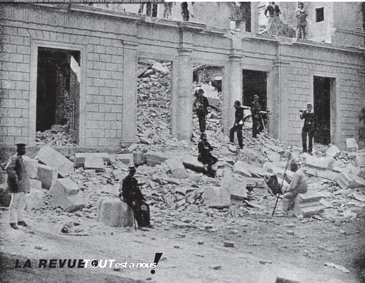
Démolition de la maison de Thiers - Gravé et imprimé par Charaire et Cie
